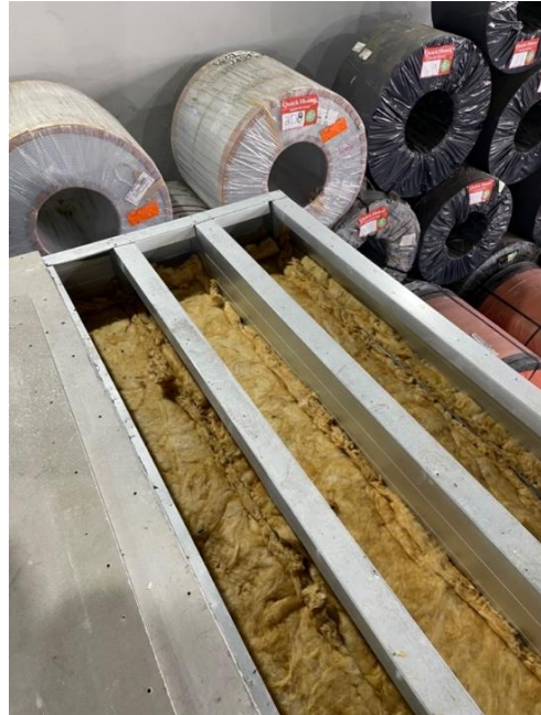
Figura 33 – Fixação da vedação vertical do segundo pavimento
