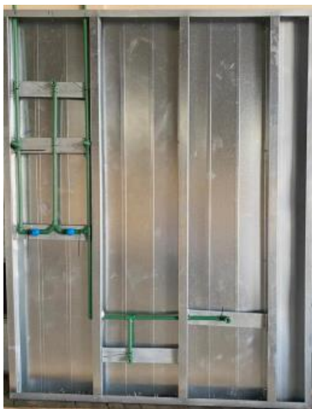
Figura 26 – Colocação e fixação da instalação hidráulica
