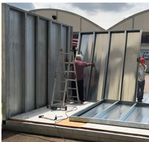
Figura 17 – Instalação dos painéis metálicos
