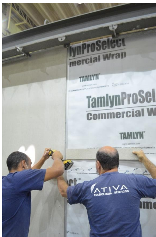
Figura 24 – Fixação da chapa cimentícia
