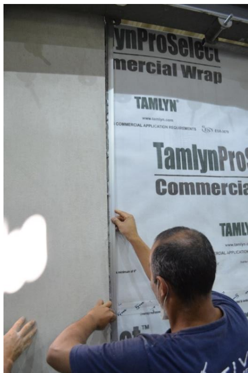
Figura 23 – Fixação do perfil de alumínio para juntas entre chapas cimentícias
