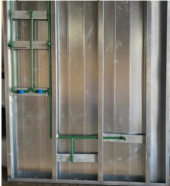
Figura 9 – Instalação hidráulica e reforço nos locais de acoplamento
