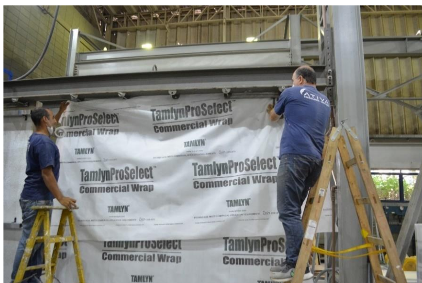
Figura 19 – Fixação da barreira resistente à água e permeável ao vapor d'água sobre os painéis metálicos
