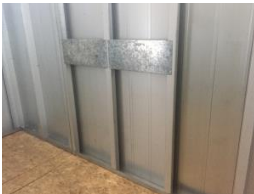
Figura 25 – Reforço metálico para peças suspensas
