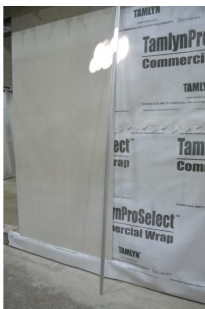
Figura 21 – Posicionamento da chapa cimentícia
